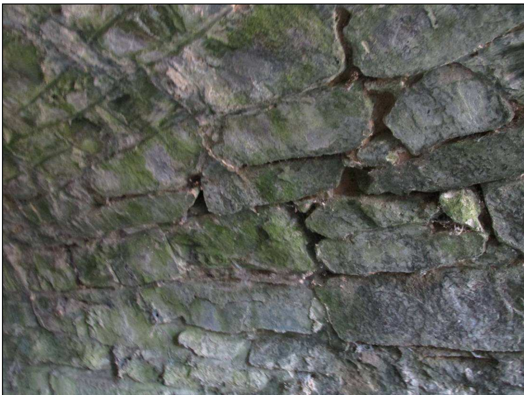
Obr. č. 8 – detail na lokálně porušené zdivo klenby - cca 2 m vpravo od čela propustku - vypadané spárování zdiva, v místech opadů odhalena silně degradovaná malta
